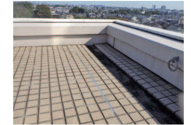
▲屋上スラブ全面リニューアル
