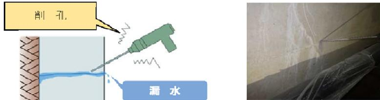
削孔した穴に高圧注入用プラグ（ニックナイン）を差し込み、8mmソケット（インパクトドライバー）やソケットドライバーで締め込む。
