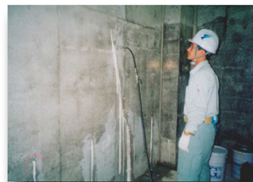
● 躯体裏面への注入状況 セパ穴から戻ってきている「G」
